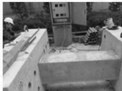
UHPC 包覆補強
