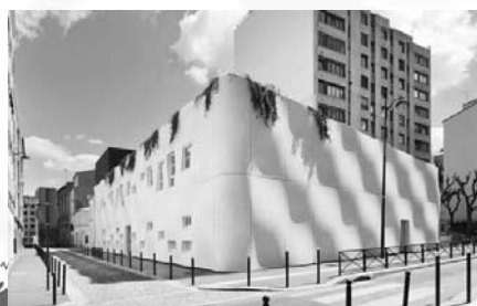
法國巴黎隔熱防水牆
