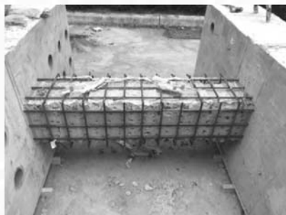
鋼筋網鋪設
